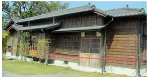
日本家屋の修復、保全が進む
