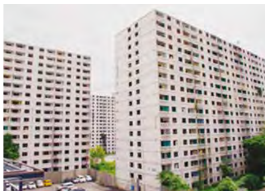
閉鎖されて廃墟と化した集合住宅
