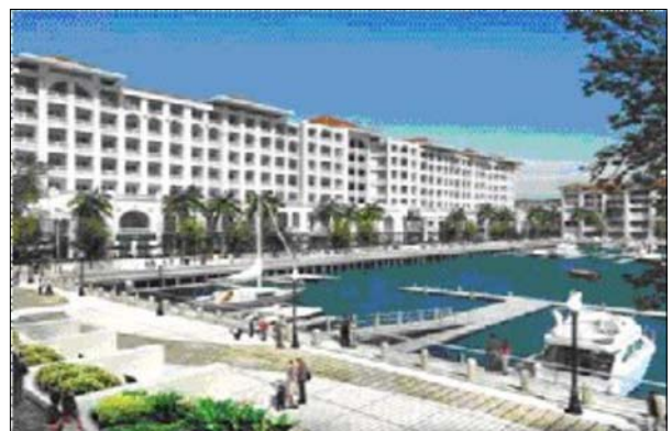
どんどん魅力的になるペナンの不動産 マリーナに建設中のアパート
