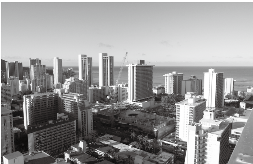
ワイキキトレイドセンター改修工事の様子
